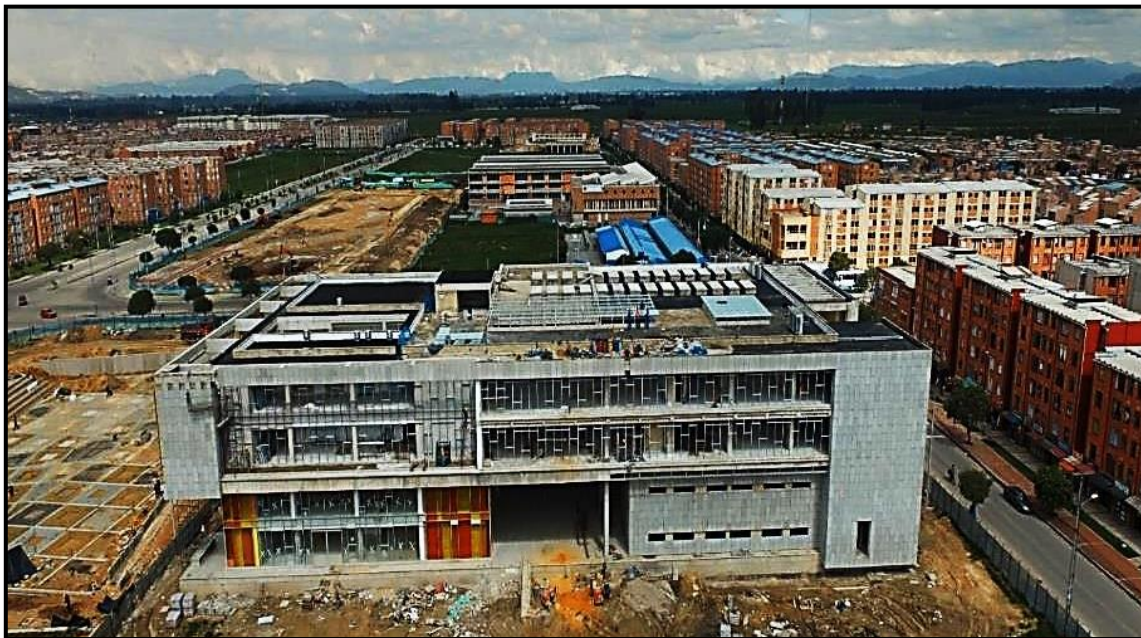
Imagen 5. Vista General Bloque 3 – Edificio Administrativo y Biblioteca
