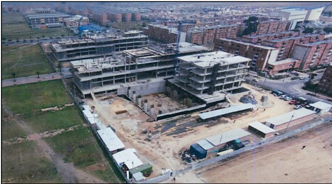
Imagen 2. Estado del Proyecto Ciudadela Educativa el Porvenir Febrero de 2015
