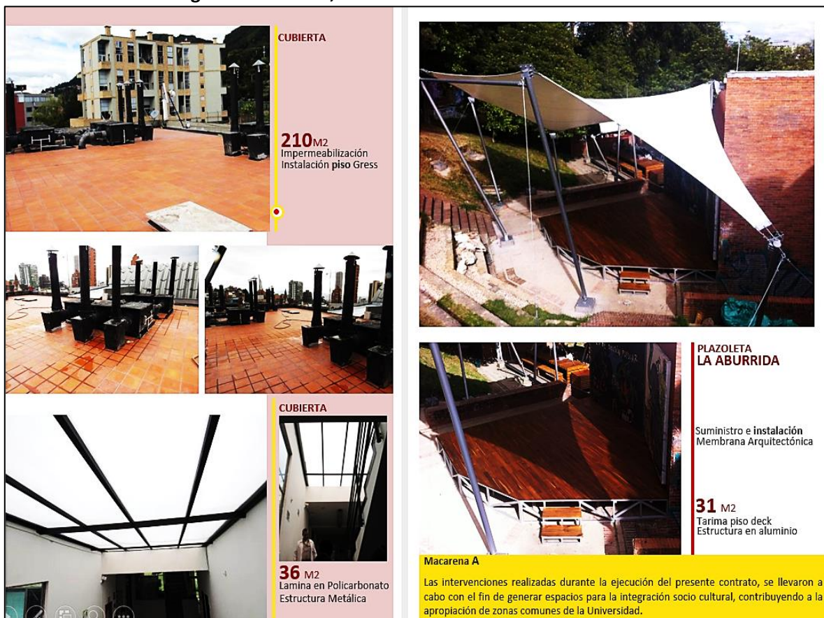
Imagen 52. Cubierta, Plazoleta la Aburrida Sede Macarena A
