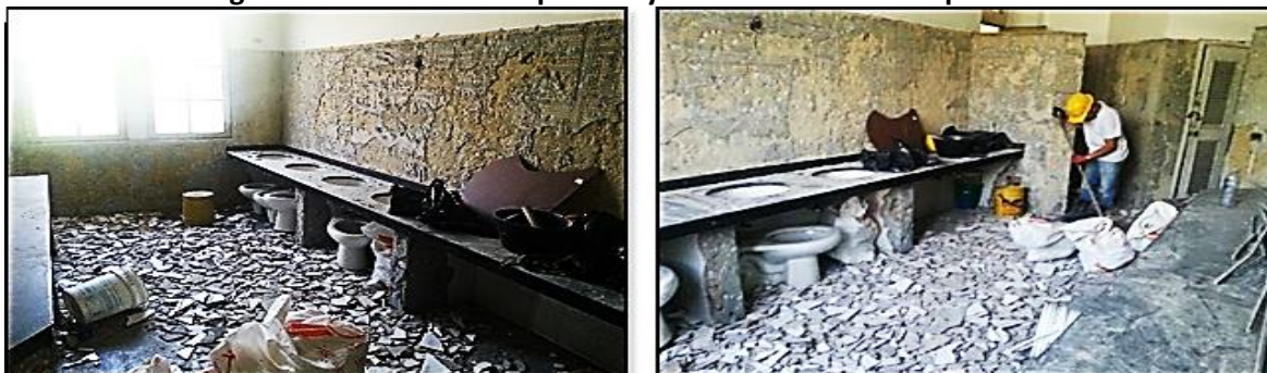
Imagen 30. Desmonte de Aparatos y Demolición de Enchape en Baños
