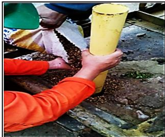
Imagen 13. Instalación de Piezómetros
