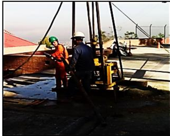
Imagen 12. Perforaciones Mecánicas para Extracción de Muestras
