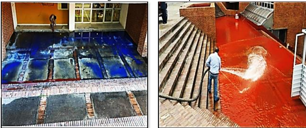
Imagen 10. Pruebas de Estanqueidad
