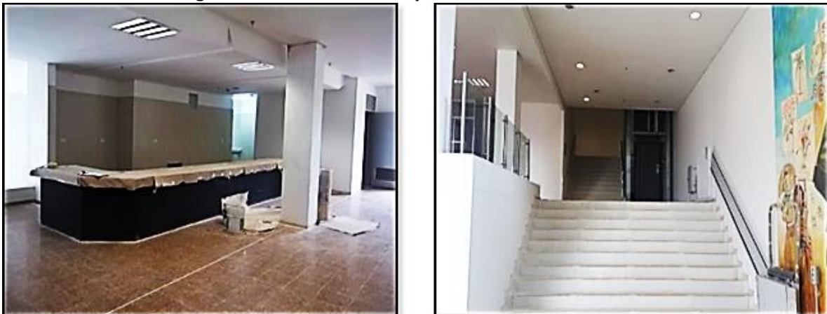
Imagen 8. Acceso a Cafetería y Ascensor – Cafetería Central
