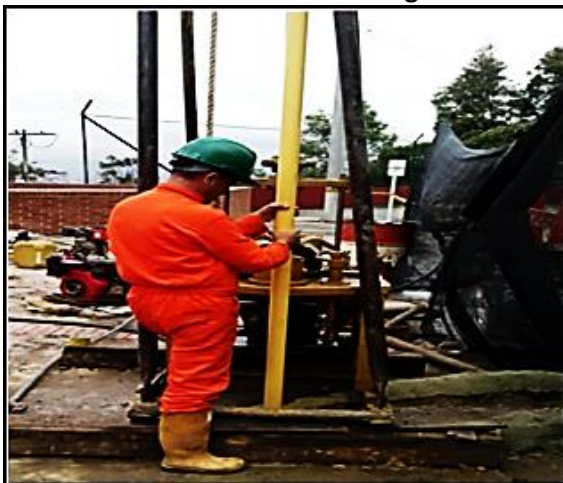
Imagen 13. Instalación de Piezómetros
