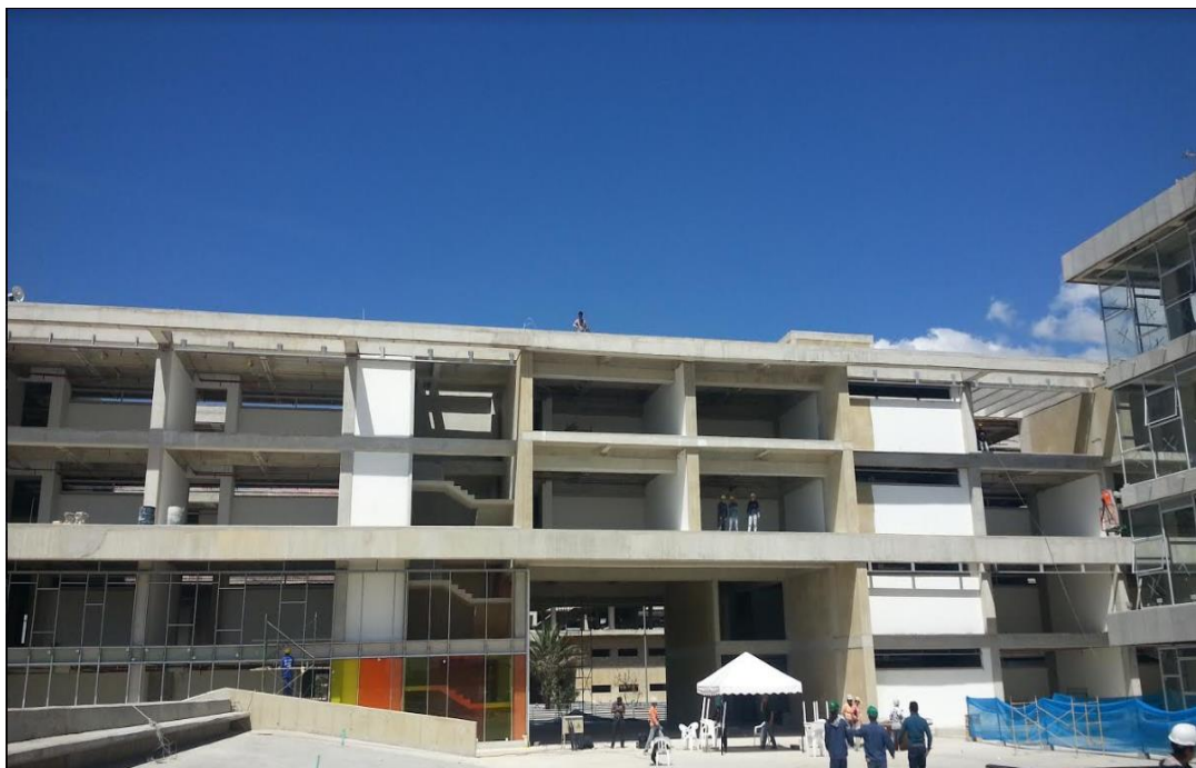
Detalle construcción Bloque 2.
